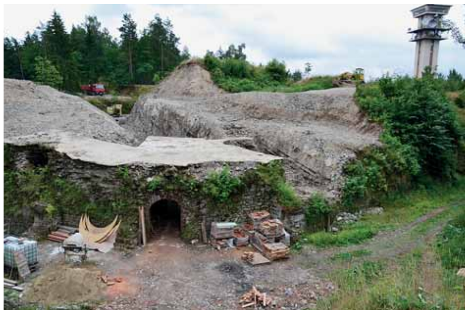
Fort Radíkov v těchto měsících prochází velmi náročnou obnovou.
